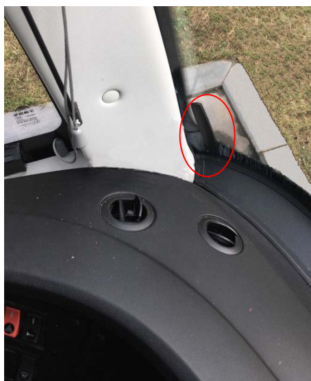
Figure 2-16 Instalación interior de Antena de Red Móvil
